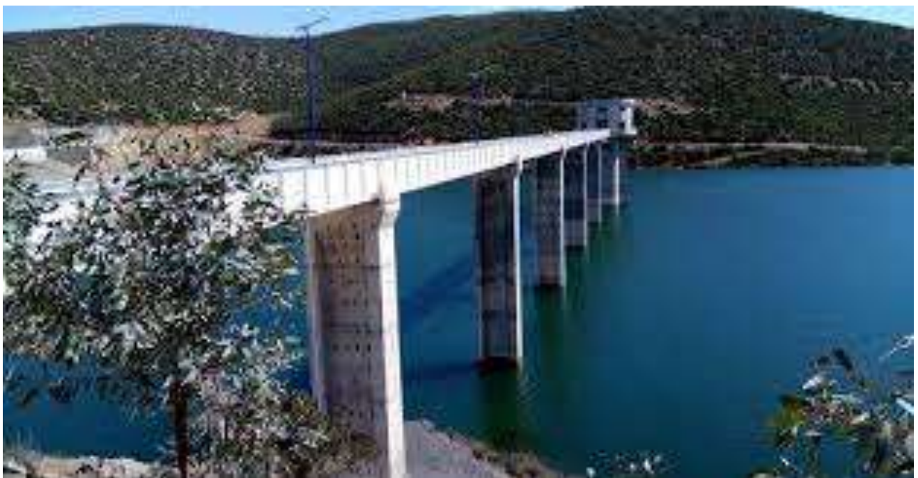
BARRAGE BENI SLIMANE – سد بني سليمان
